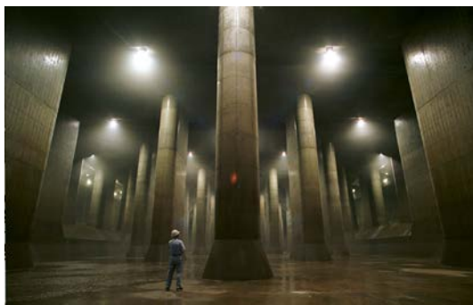
首都圏外郭放水路の調圧水槽（「地下神殿」と呼ばれている）国土交通省江戸川河川事務所 HP より
