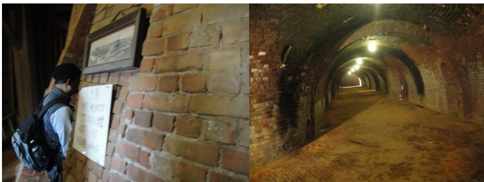
旧日本煉瓦製造所のホフマン6号窯 (2011.11.13撮影) (現在、保存修理の耐震補強工事中)
