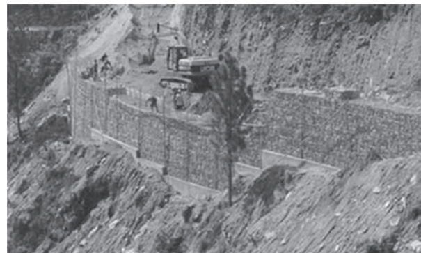
図－1 適正技術の一例（鉄線籠を用いた擁壁） 4)
